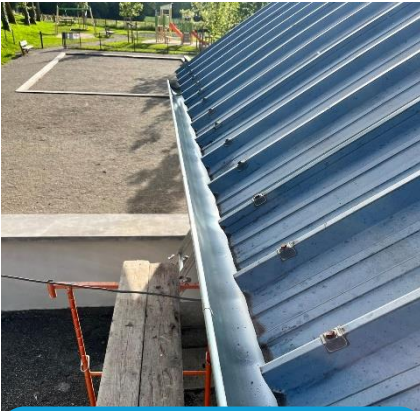
Remplacement des chéneaux à la salle des fêtes
