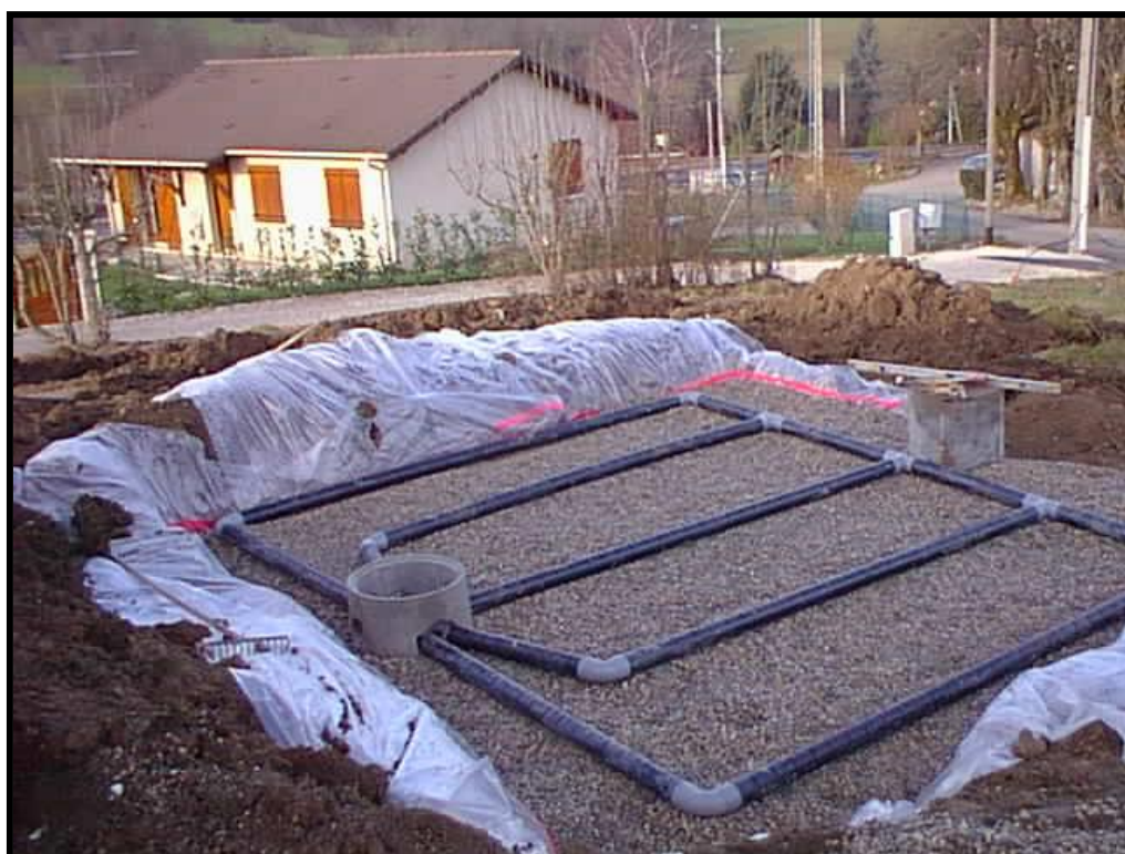
Filtre à sable vertical drainé étanche en cours de réalisation
