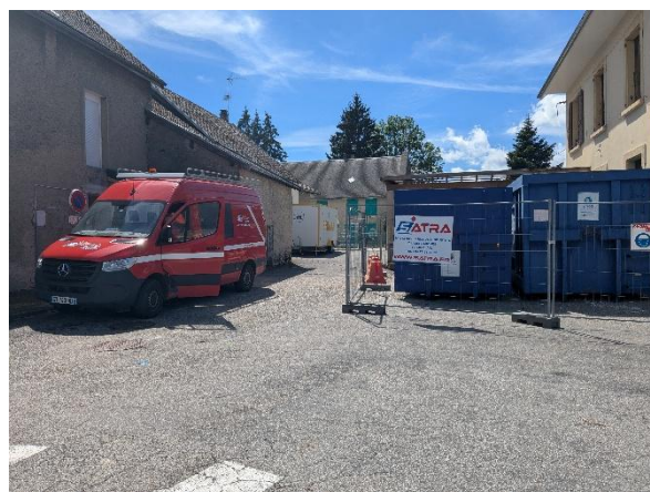
Travaux à l'ancienne école
