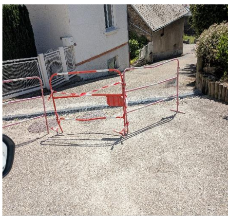
Travaux de récupération d'eau à la Cime des Blais
