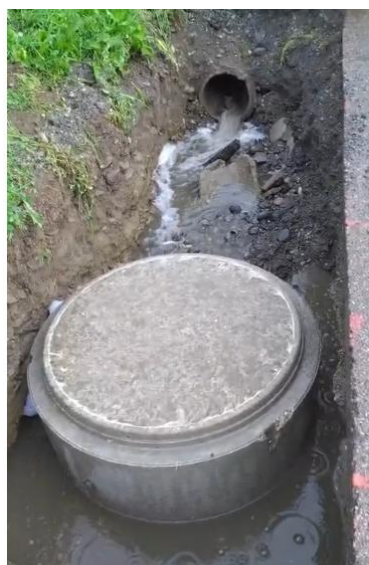
Réparation du tuyau d'eau pluviale sur le parking de la salle et pose d'un regard
